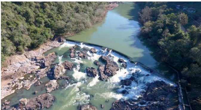
FIGURA 5 – Vista geral da Barragem Principal e reservatório de uma PCH no Rio Grande do Sul
