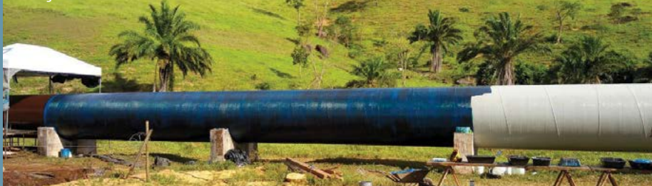
Instalação de fibras de vidro e carbono
