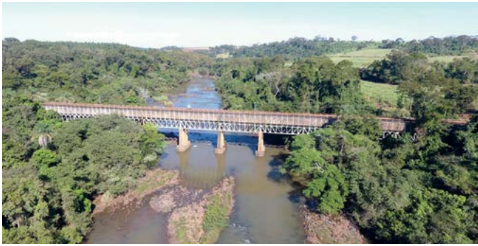
FIGURA 3 – Vista aérea do canal adutor sobre estrutura metálica na região do canyon
