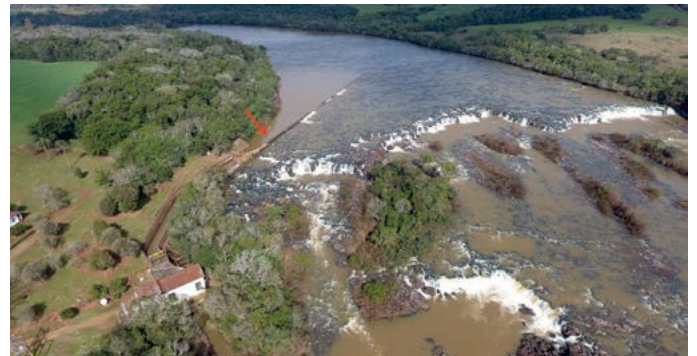
FIGURA 7 – Vista geral da usina nº 3, com o barramento mais a montante, e a entrada do canal adutor mostrada pela seta
