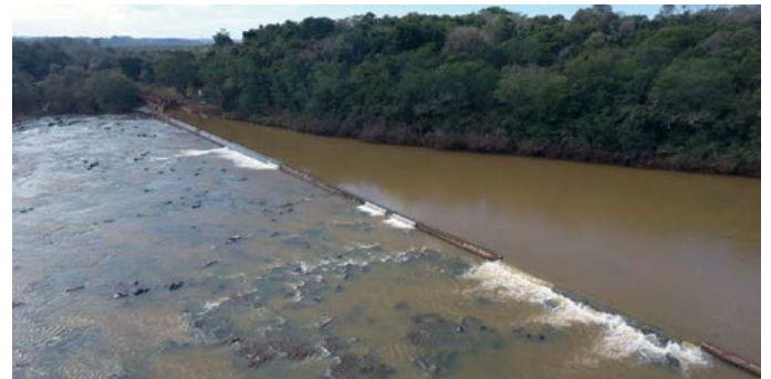
FIGURA 8 – Vista geral da barragem principal dessa usina, a qual anteriormente só podia ser inspecionada a partir da Tomada d'Água, e sua extremidade direita hidráulica
