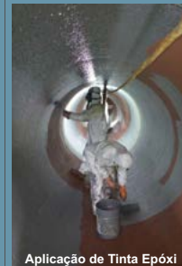
Aplicação de Tinta Epóxi
